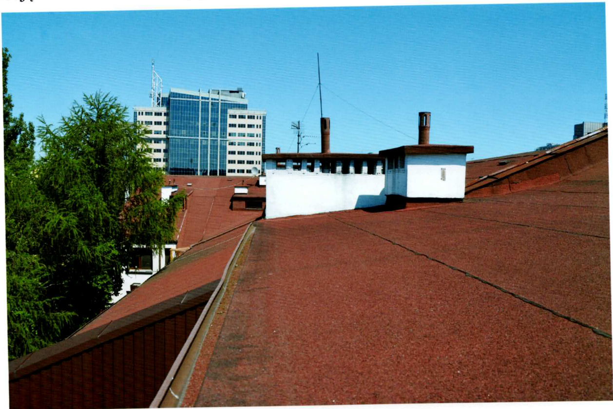
Zdjęcie 24. Pokrycie papowe dachu.
